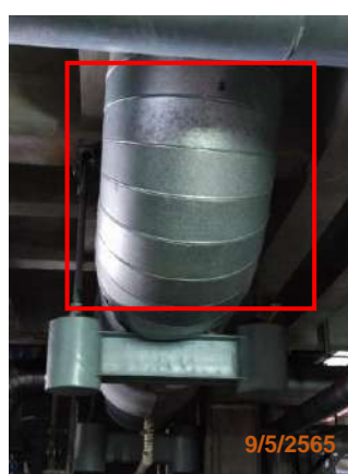
รูปที่ 2-41 ฉนวนกันความร้อน บริเวณระบบท่อไอน้ำ
