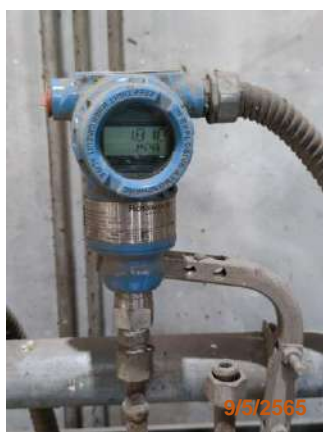
รูปที่ 2-62 Pressure Transmitter ของหม้อไอน้ำ
