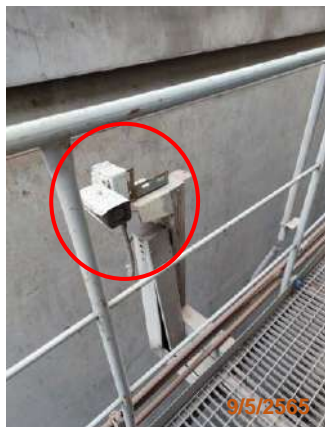
รูปที่ 2-60 การติดตั้งกล้องวงจรปิดสำหรับตรวจสอบ ระดับน้ำใน steam drum จากระบบเครื่องวัดระดับ น้ำแบบ bi-color
