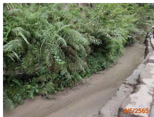
รูปที่ 2-21 รางระบายน้ำรอบพื้นที่โครงการ
