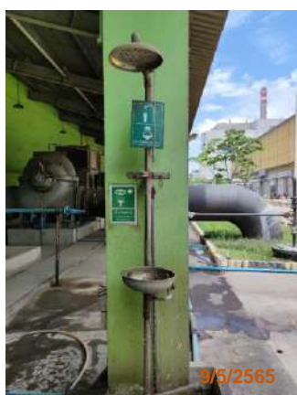
รูปที่ 2-46 ที่ล้างตาฉุกเฉิน
