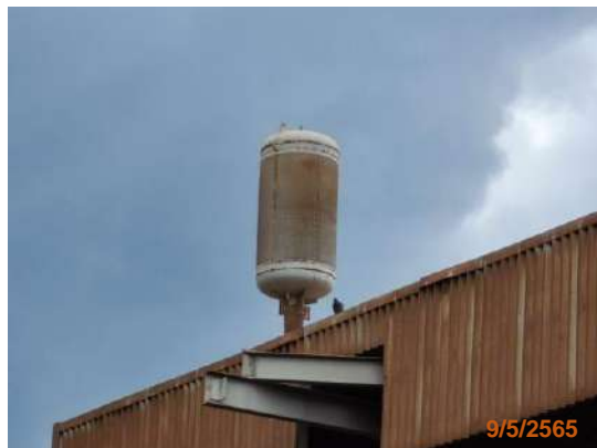
รูปที่ 2-13 อุปกรณ์ลดเสียง (Silencer)
