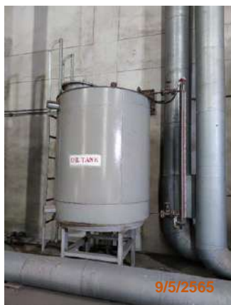
รูปที่ 2-68 การติดตั้ง Emergency Gravity Oil Tank ภายในโรงไฟฟ้า
