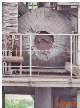
รูปที่ 2-55 Steam Drum ของหม้อไอน้ำ
