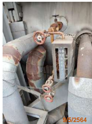
รูปที่ 2-61 เครื่องวัดระดับน้ำ
