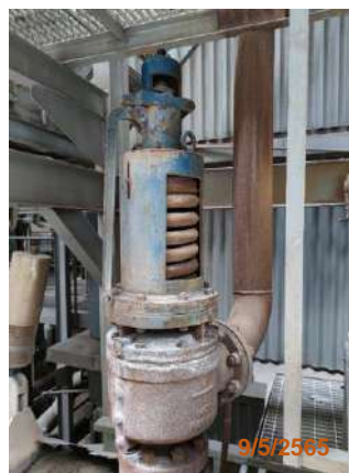
รูปที่ 2-57 Safety Valve ของหม้อไอน้ำ
