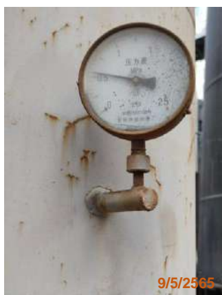
รูปที่ 2-58 Pressure gauge ของหม้อไอน้ำ
