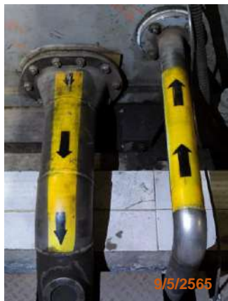
รูปที่ 2-66 ระบบท่อน้ำมันเลี้ยงแบร์ริงของ Turbine & Generator
