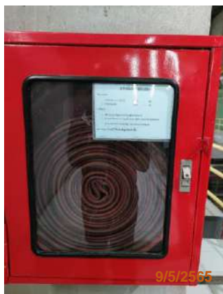
รูปที่ 2-50 ตู้เก็บสายดับเพลิง พร้อมอุปกรณ์ดับเพลิง ภายในโรงผลิตไฟฟ้า
