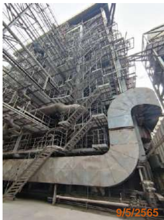
รูปที่ 2-54 ตัวอย่างอาคาร Boiler ที่มีทางเดินและบันได พร้อมราวกันตก
